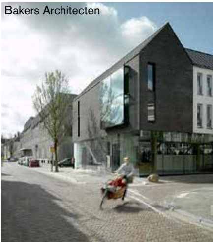
Takavslut utan utsprång förstärker gavelmotivet.
