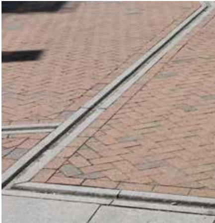
Marktegel på gården harmonierar med omgivande fasader. En öppen dagvattenränna leder vattnet ut från gården.
