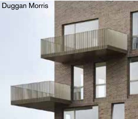
Stålräcken vars kulör harmonierar med fasad.
