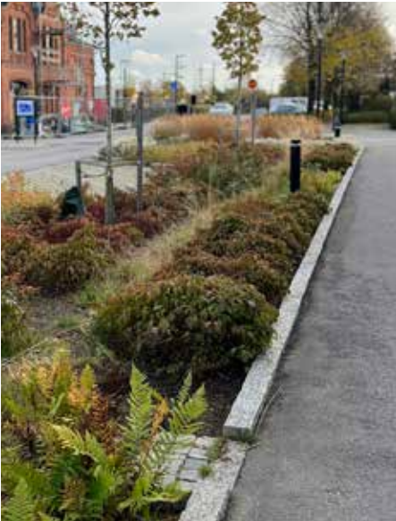
Planteringsytor med regnbäddsfunktion dit vattnet från både stuprör och gata leds för rening bevattning.
