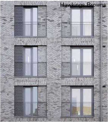
Indraget fasadliv. Fönsterpartier ner till golv.
