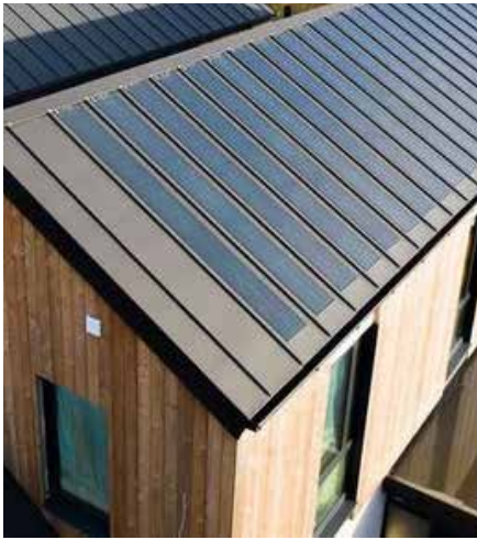
Solpaneler som kamoufleras i takmaterialet.
