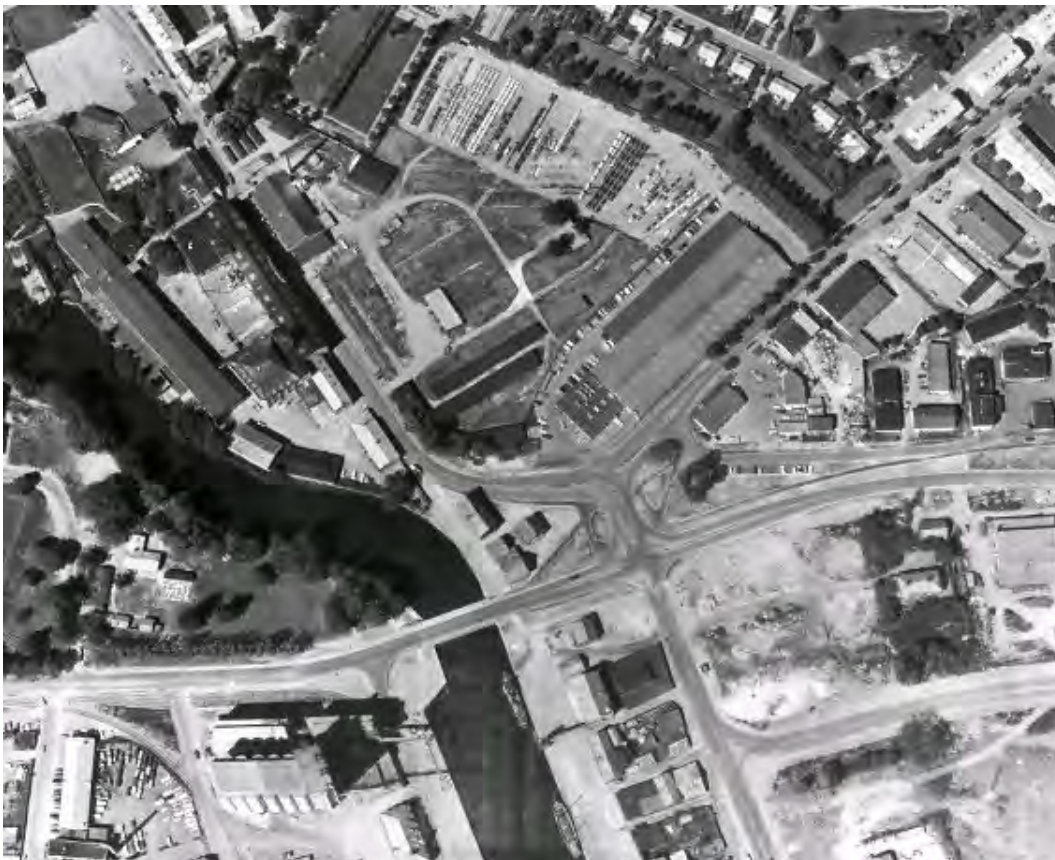
Flygfoto taget efter 1962 (silobyggnaden t.v. uppfördes då) och 1966 då den nya vägbron öppnades. Här återstår endast fyra sjöbodar norr om Hamnvägen och den äldre Skeppsbrovägen är nu omlagd för att skapa en säkrare trafikföring genom området och omdöpt till Folkungavägen. Källa: Sörmlands museum.
