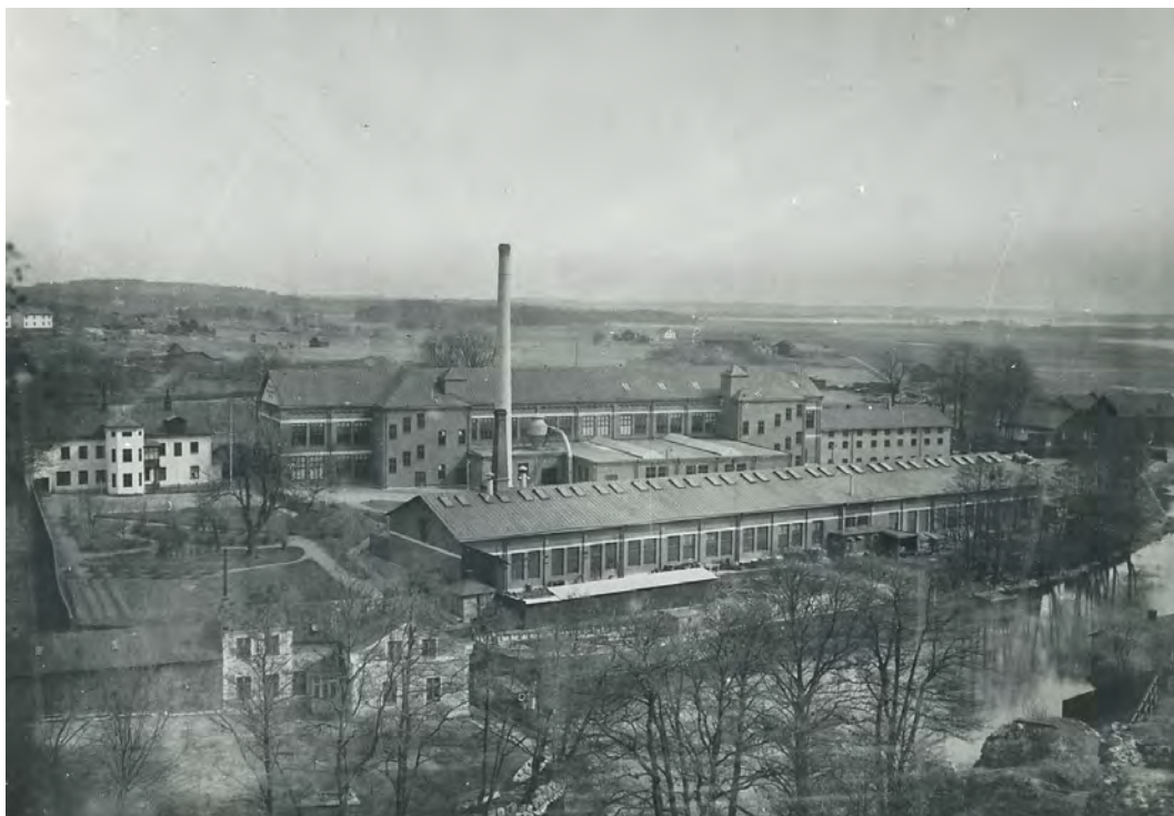
NK verkstäder ca 1910 i foto från Nyköpingshus. Anläggningen fyller upp hela södra delen av det gamla varvsområdet. Mot Skeppsbrovägen ligger snickeri och fanérkällare, mot ån den långa metallverkstaden. T.h. skymtar de gamla magasinerna från 1700-talet. Kungsladugårdens öppna landskap breder ut sig mot öster. Källa: Sörmlands museum.
