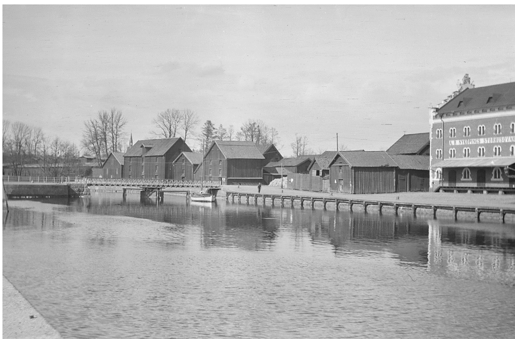
Vy från sydväst över östra sidan av hamnen. Antalet äldre sjöbodar/magasin är omfattande norr om storhuskvarnen. T.v. i bild skymtar en byggnad tillhörig NK:s verkstäder. Foto u.å. men troligen tagen kring 1930. Källa: Sörmlands museum.
