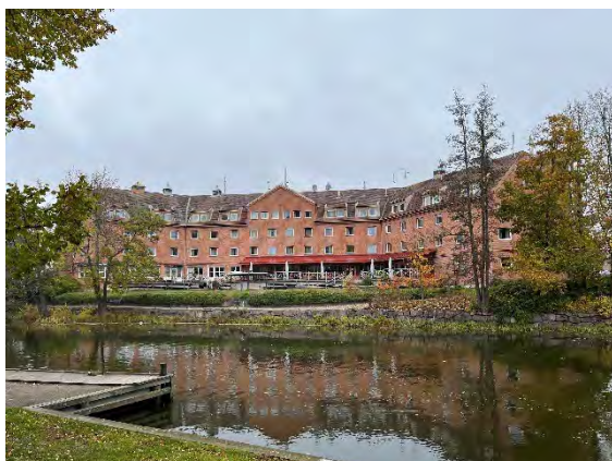
Foto t.v. Kvarteret Kompaniet 30 från sydväst.
